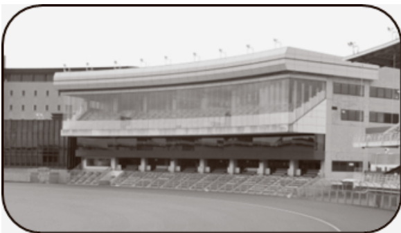
【写真2】1号館周辺
